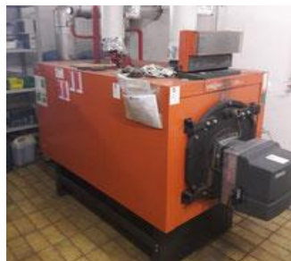
Sanierung Anlagen Optimierung Verteilung Erneuerbare Energien Wärmerückgewinnung
